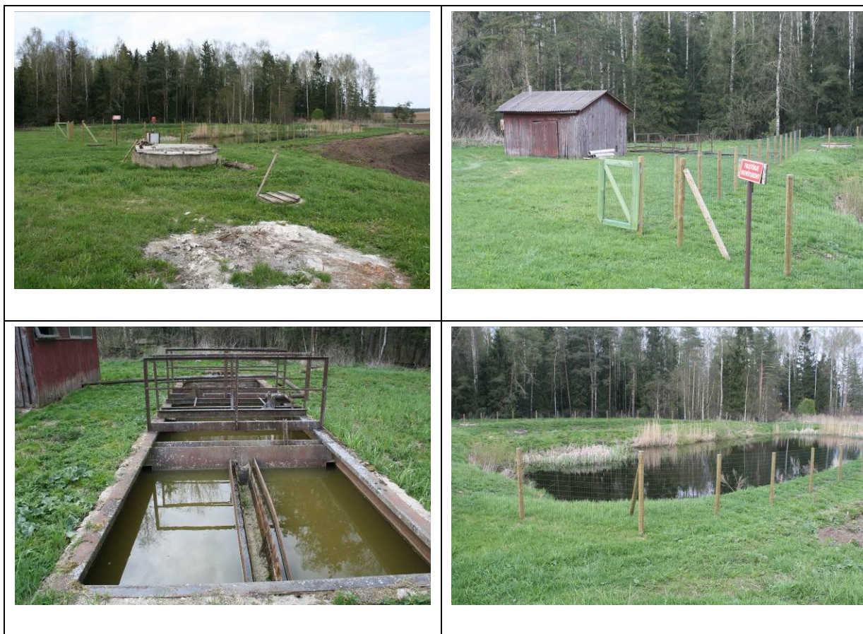
Joonis 7. Aarna küla reoveepuhasti. Fotod: OÜ Alkranel 6.05.2015.
